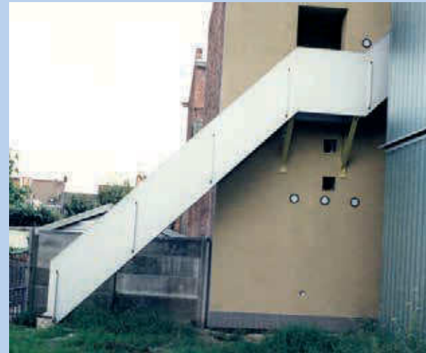
Borstwering met volle aluminium plaat
