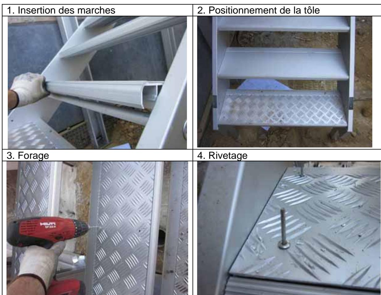
**Attention :** il faut être prudent lors de l'insertion des marches pour ne pas griffer les faces intérieures des limons de la volée. Il faut donc bien **insérer les marches exactement dans le même axe que les limons de la volée.**
