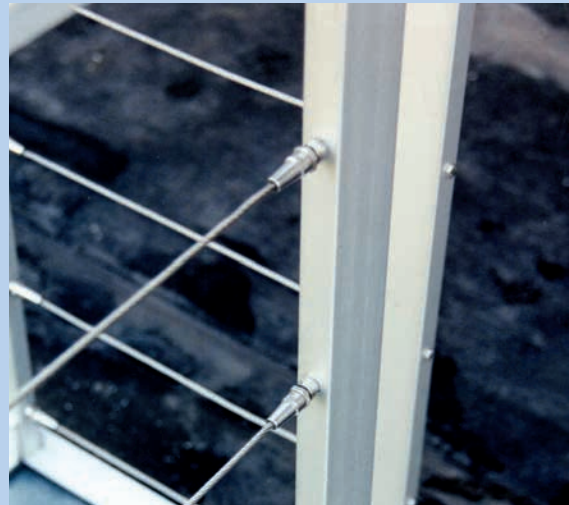
Borstwering met roestvrij stalen kabels
