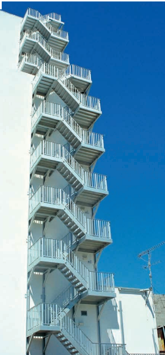
Voorbeeld van een trap opgehangen aan de gevel
