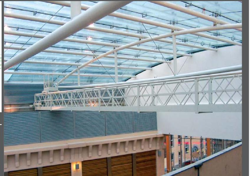
Exemple: Plate-forme rigide avec nacelle mobile
